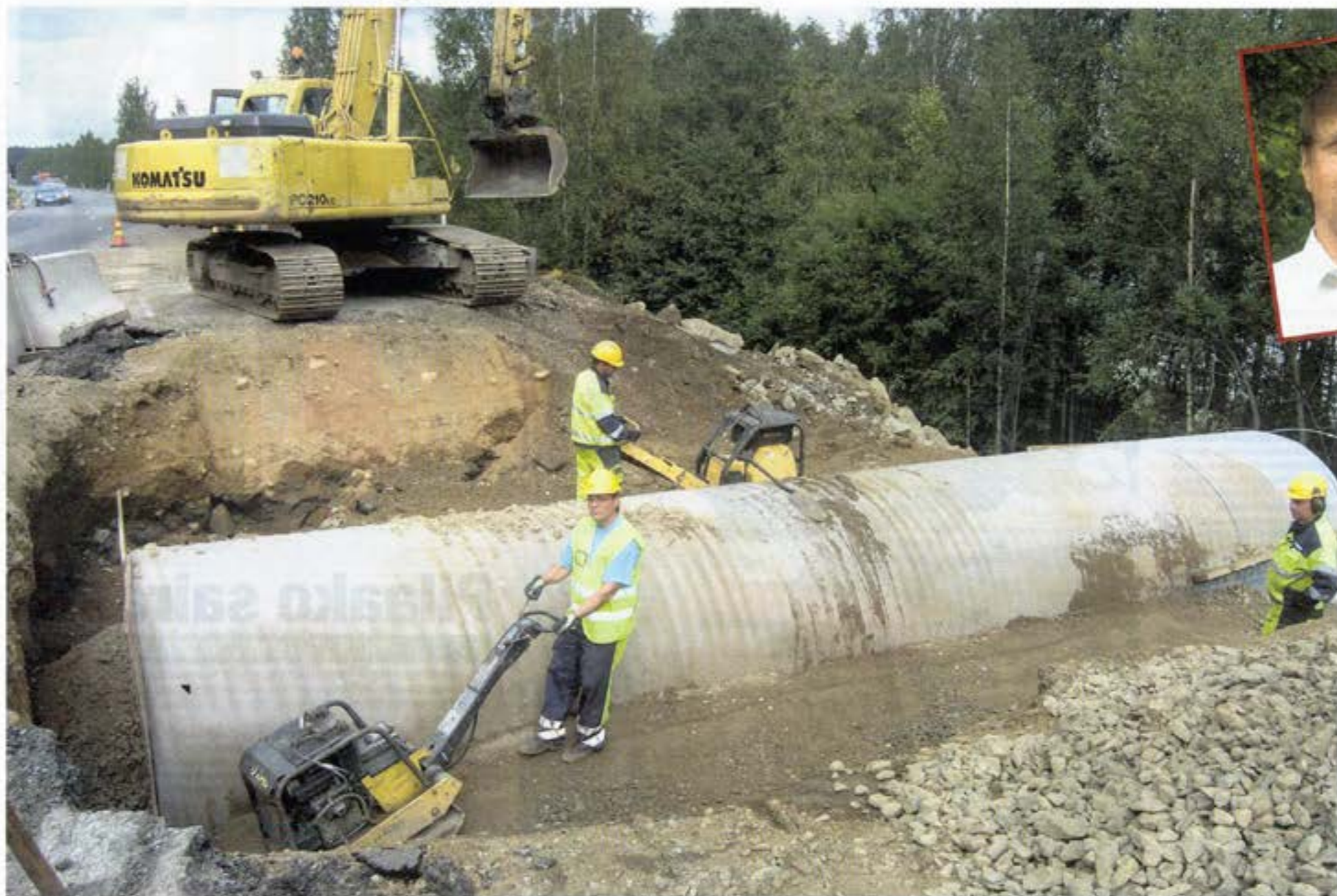
Yleiselle tielle piti tehdä kiertoreitti tunnelityömaan ajaksi. Lisäksi tunneli oli rakennettava kahdessa osassa.
