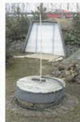
Yksityiseen tunneliin ei ole kukaan asialla. Sen takaavat ovet ja lukot.
